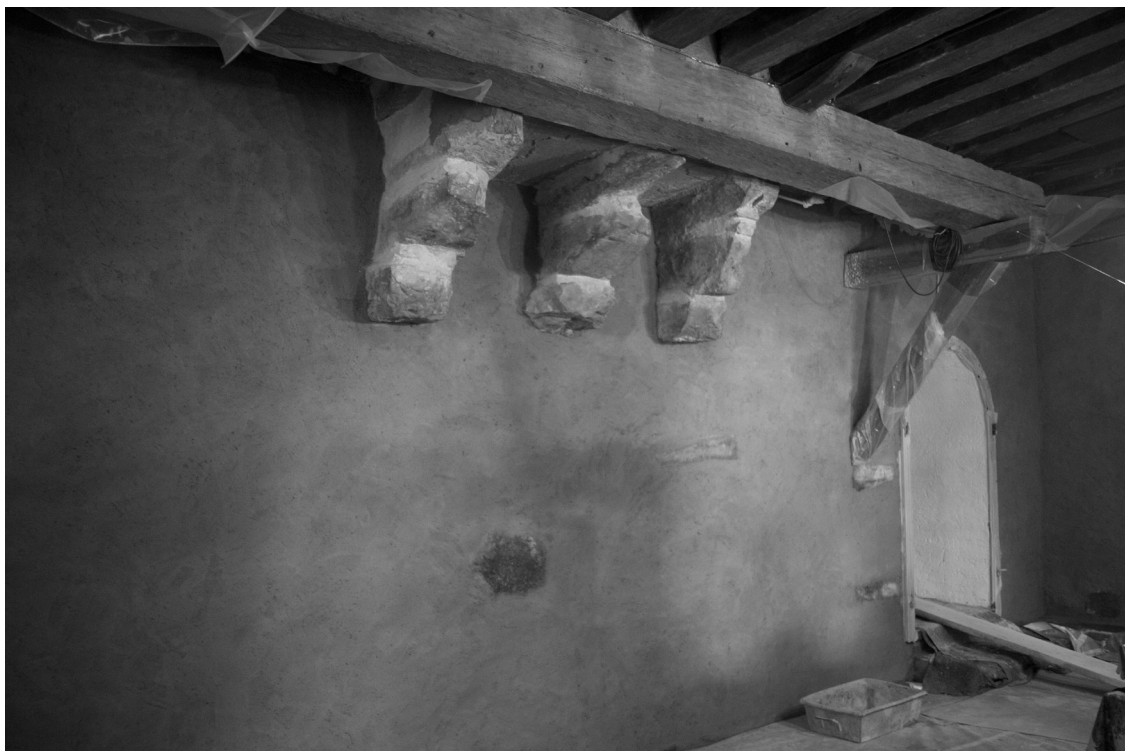
Un chauffage électrique a été installé et l'une des fenêtres a été remplacée.
