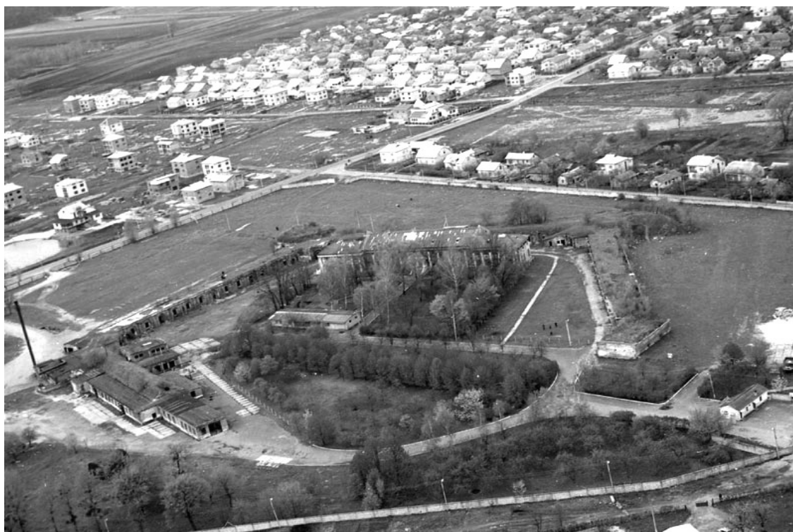
Vue aérienne: les casemates entourent le palais
