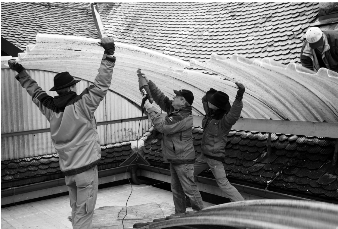
Le démontage de l'ancienne couverture
