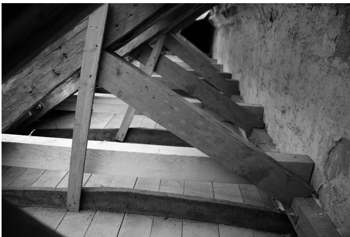
Renforcement actuel de l'avant -toit
