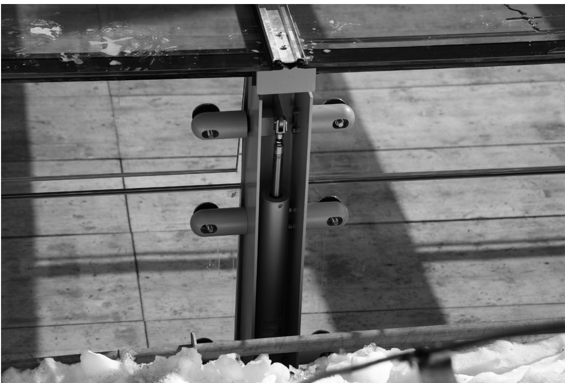
Un des vérins qui permet d'ouvrir les lames mobiles de la verrière
