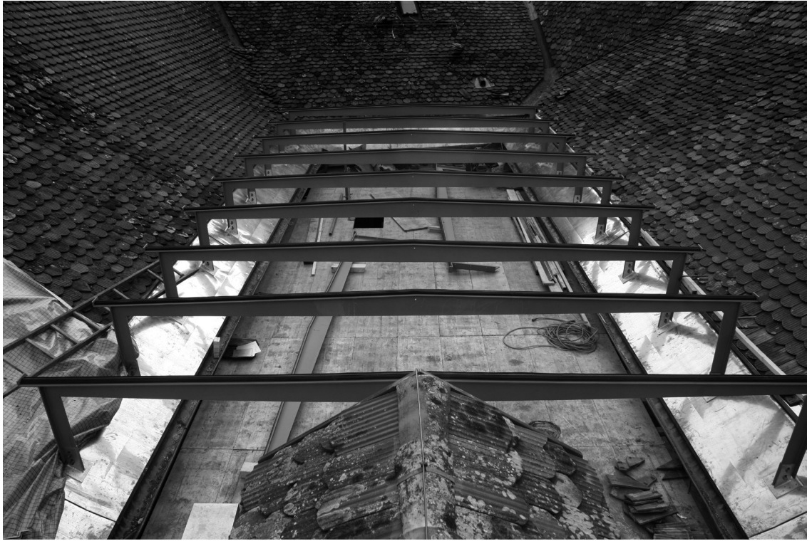
L'hélicoptère a livré les structures métalliques (p 40) et les verres (ci-dessous)
