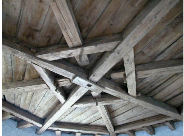
Charpente (enrayure) de la pièce du deuxième étage de la tour.
