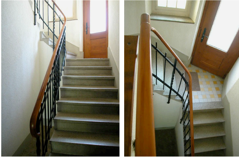
La cage d'escalier dans son état actuel
