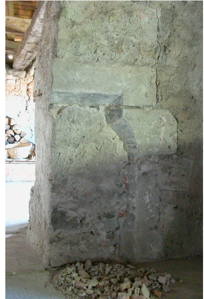
Détail de la fenêtre à coussinets concaves découverte dans les combles (2.03).
