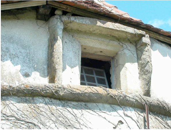
Tour du « colombier », détail de la fenêtre du deuxième étage avec boudin formant larmier et baie à accolade du rez-de-chaussée.
