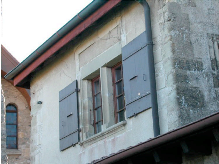
Façade occidentale, détail de la fenêtrage de l'annexe.
