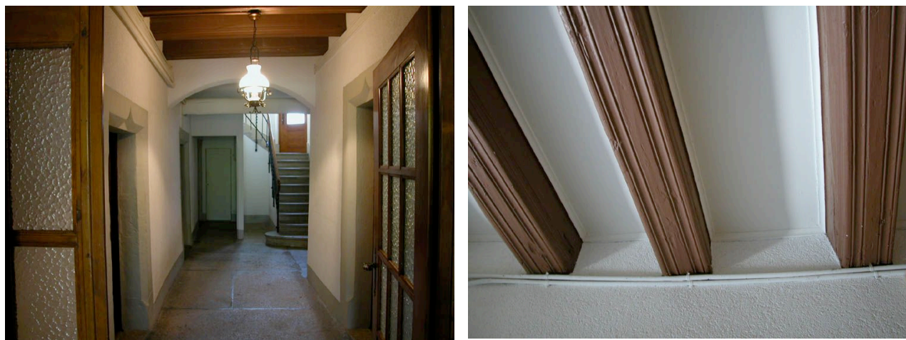
Rez-de-chaussée, l'allée centrale (0.02 et 0.03) et son plafond à poutres moulurées (XVII e siècle).
