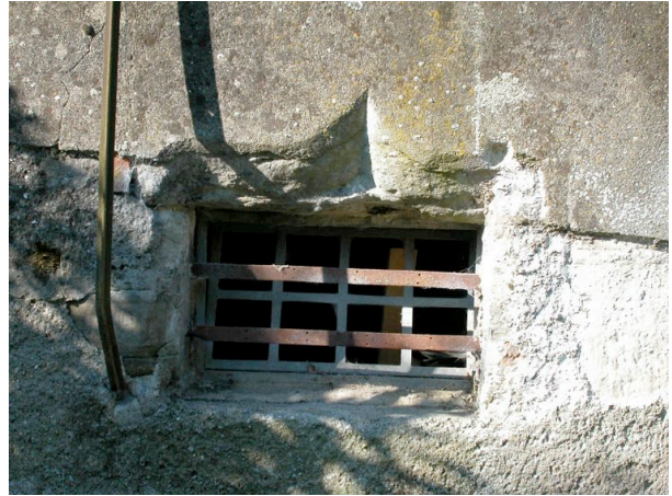
Tour du « colombier », détail de la fenêtre du deuxième étage avec boudin formant larmier et baie à accolade du rez-de-chaussée.
